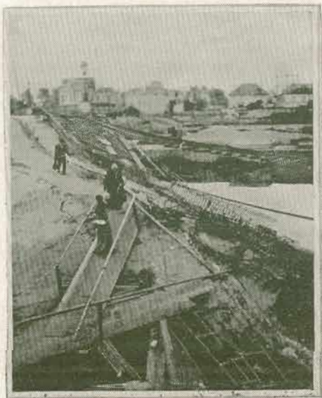
Vista del mismo puente con un pasaje provisional construido por los franceses.
