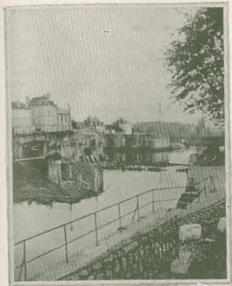
Uno de los puentes del Aisne, en Soissons, destruido por los alemanes y reparado por los ingenieros ingleses.
